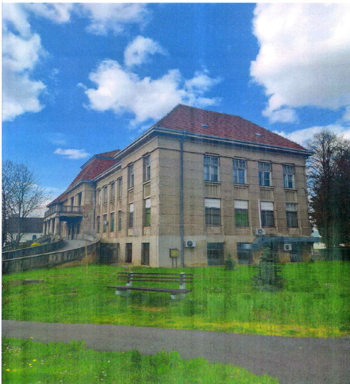
Fotografija 2.: Zgrada kirurgije
