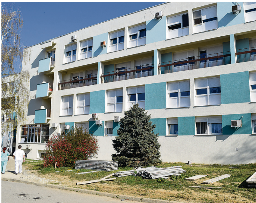
Zgrada Opće bolnice poprimila je posve nov izgled
