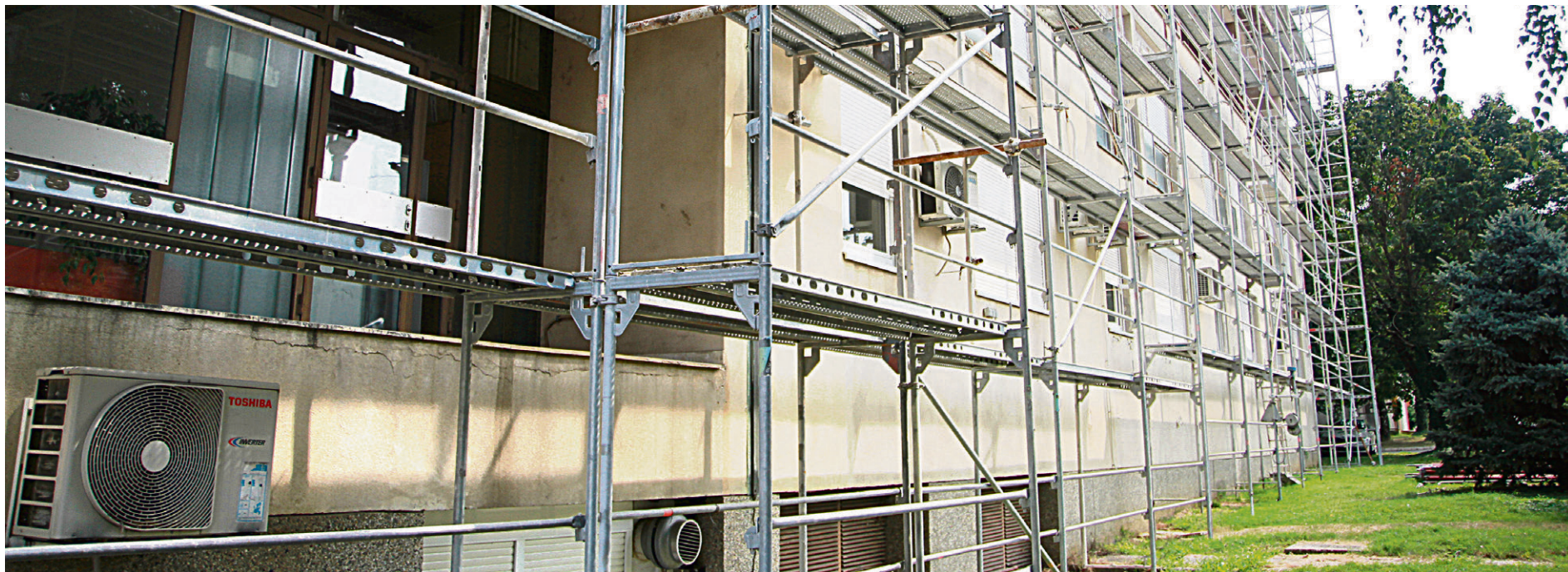
Oko zgrade nove bolnice postavljene su građevinske skele
